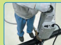
ハンドルを逆回転させてスピンドルを一番上まで引き上げ、サドル分水栓の閉止、切粉排出用ドレン弁を閉じます。
