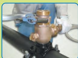
サドル分水栓に穿孔サイズと同径のアタッチメントを取り付け、分岐側に穿孔時の切粉を排出するドレン弁を取り付けます。
