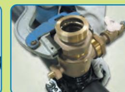
電源コードを外し、サドル分水栓より穿孔機、アタッチメントを取り外し、キャップをします。
