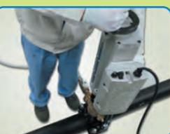
ハンドルを取り付け、切削刃が管頂に当たるまでゆっくり右回転させて降ろします。
