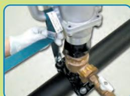
サドル分水栓のボルトにアイナットを取り付け、穿孔機の取っ手部に反転防止ベルトを通してサドル分水栓と固定します。
