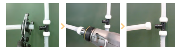
パイプを直角にカットします 専用工具で拡張します 継手に差し込み終了です
