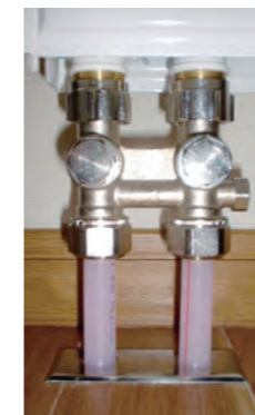
eval PEXパイプは 密閉式・開放式のいずれにも ご使用できるパイプです
