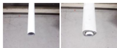
②管に継手を施工し、耐候性保温材が継手端面まで覆っていることを確認してください。(継手の施工は「継手施工方法」を参照)
