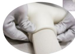
異形チーズを施工する場合は、先に小口径側の継手カバーの口を絞った状態で施工してください。
