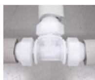
③継手に継手カバーを被せ、継手カバーが耐候性保温材の端面を覆っていることを確認してから、耐候性保温材、継手カバーの上から耐候テープを隙間なく巻きつけてください。
