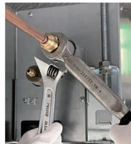
※締付け後、第1標線と継手端面に約1mm程度の隙間が発生します。
