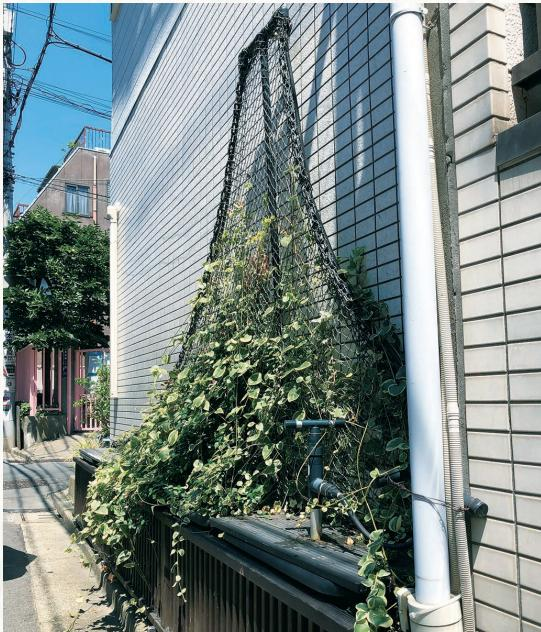
写真4 横から見た「富士」。雨どいから雨水を取水、手動ポンプによりネット上部から植物に水を供給する
