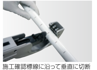
施工確認標線に沿って垂直に切断
